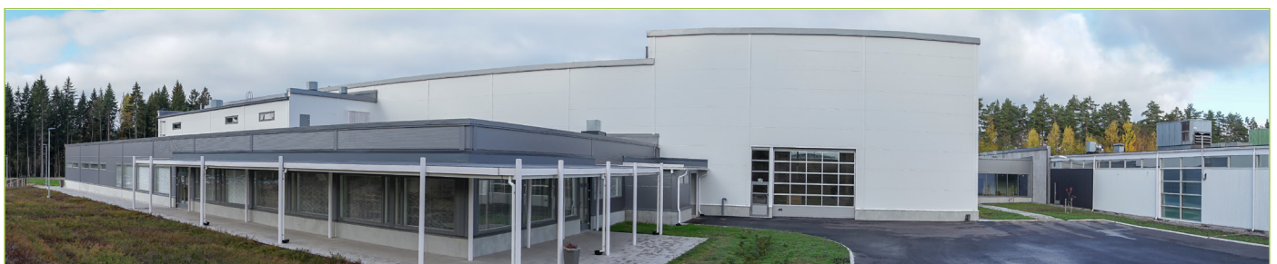
Unterjährig wurden eine Reihe Energieinvestitionen durchgeführt, unter anderem in den neuen Räumlichkeiten des Unternehmens LOVAL, das in Finnland tätig ist. Das trägt zu verbesserter Klimaneutralität in unseren eigenen Unternehmen bei, was ein natürlicher Bestandteil unsere Nachhaltigkeitsarbeit ist.
