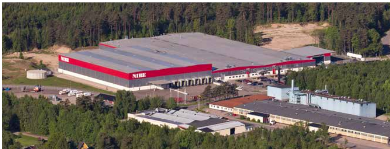
Produktionsanläggningen i svenska Markaryd tillverkar huvudsakligen bräsvärmeprodukter i stålplåt och kompletta skorstenssystem för varumärkena Contura och Premodul by Contura. Produktionstakten har ökat avsevärt under första halvåret för att möta förväntad ökad efterfrågan och säkerställa såväl god leveranskapacitet som hög leveranssäkerhet inför den kommande höstsäsongen under hösten/vintern 2016.
