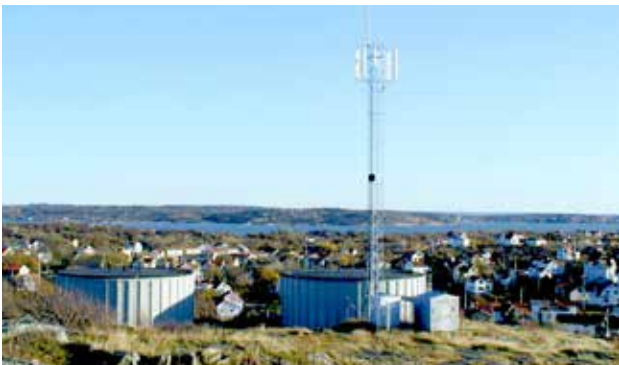
Nyförvärvade Air-Site ABs produkter inom frikyla använder naturens egna krafter (lågimpulsprincipen) för sin klimatstyrning. Kunderna får en jämn och bra temperatur året om, vilket bidrar till kraftiga energibesparingar. Bolaget har varit pionjärer inom Grön Teknik och genom samarbete med stora företag såsom TeliaSonera och Ericsson, har de utvecklat marknadens mest effektiva energibesparingslösningar som idag är en självklarhet hos telekomoperatörerna.
