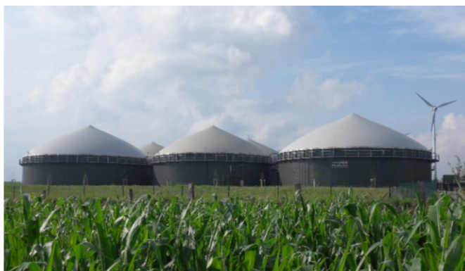
Power-to-Heat-systemet från det nyförvärvade bolaget ELMESS-Klöpper Group tillåter operatörer av kraftvärmesystem med ansluten kylfunktion att minska inmatningen till nätet genom att använda el till varmvatten. Exempel på operatörer är biogasanläggningar, vindkraftverk och lokala energileverantörer.
