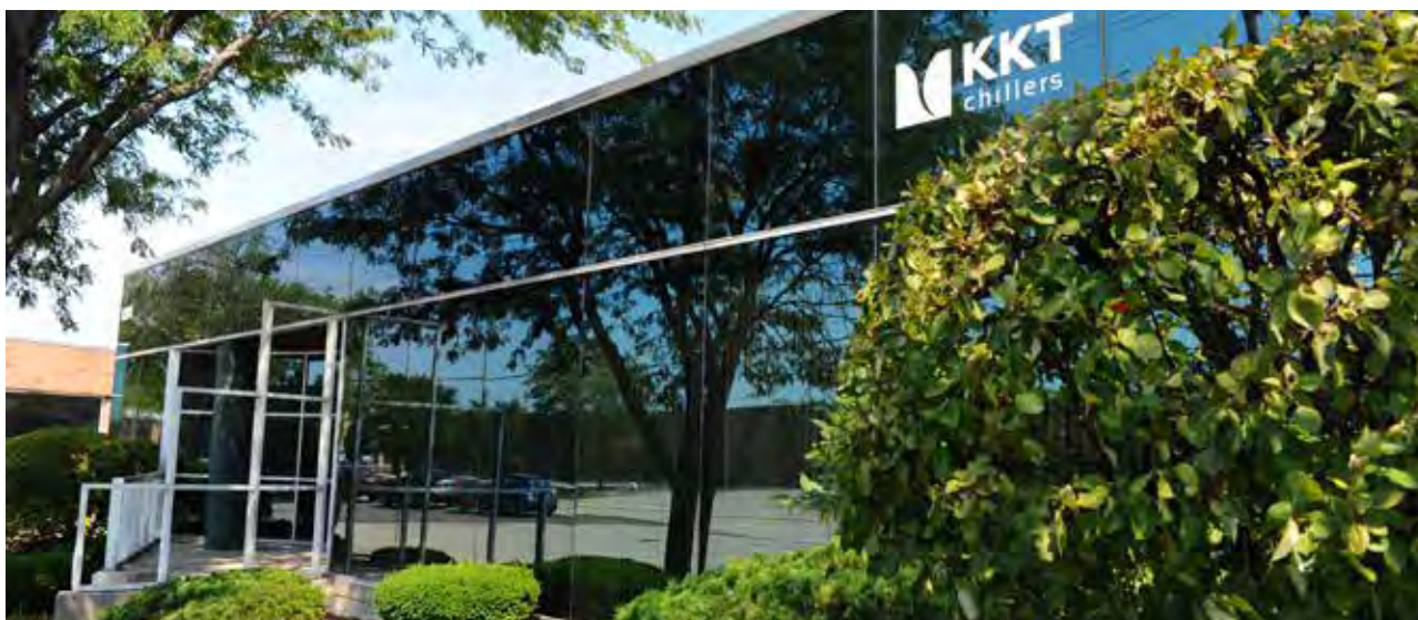
KKT Chillers i Chicago, USA fokuserar huvudsakligen på service och försäljning av kylaggregat för den nordamerikanska marknaden. Produktsegmentet kylaggregat är ett område vi vill fortsätta att expandera inom. KKT Chillers var med en betydande tillväxt ett av affärsområdets mest framgångsrika företag under 2015.
