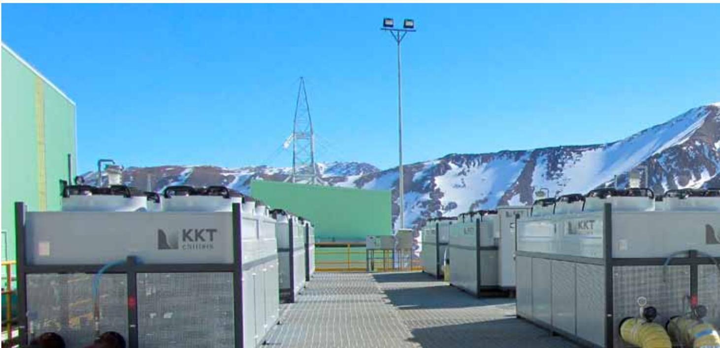
Die deutsche KKT liefert Kühlanlagen für industrielle Zwecke. Hier geht es um Kühlung von Elektromotoren und Ausrüstung für Drehzahlregelung in einem Bergwerk in Los Bronces, Chile.
