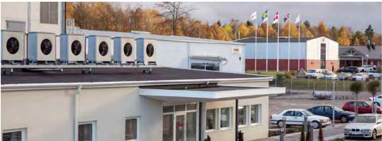
2012 wurde im Wärmepumpencenter in Markaryd eine neue Wärmepumpenanlage installiert, deren Wärmeleistung bei 180 kW liegt. Versorgt wird die Anlage durch fünf Bohrlöcher mit einer Tiefe von jeweils 160 Metern. Hinzu kommen sechs NIBE AMB-Außenlufttaggregate mit jeweils ca. 20 kW. Auch die bei Betriebsprüfungen der Produkte anfallende Energie wird rückgeführt.
