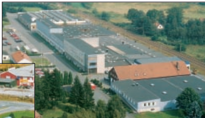
Backer Elektro-Värme AB i Sösdala.
