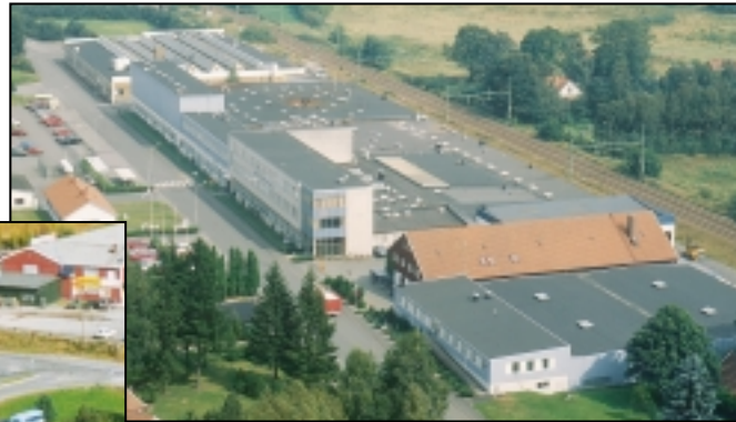
Backer Elektro-Värme AB in Sösåååå, Schweden
