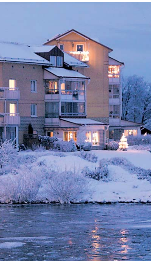
Durch Felswärmepumpen lässt sich der Energieverbrauch in größeren Gebäuden wesentlich reduzieren.
