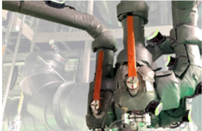
*NIBEs Tochtergesellschaft BriskHeat produziert energieeffiziente Hochleistungsheizmäntel mit Temperatursteuerung, die an verschiedenen Arten von Gasleitungen zur Verhinderung von Kondensflüssigkeit und für einen reibungslosen Prozessverlauf installiert werden. Für eine optimale Energie- und Systemleistung regeln und überwacht das Steuerungssystem von BriskHeat jeden Mantel im System einzeln. Durch diese Temperatursteuerung wird die Leistung insgesamt verbessert.*
